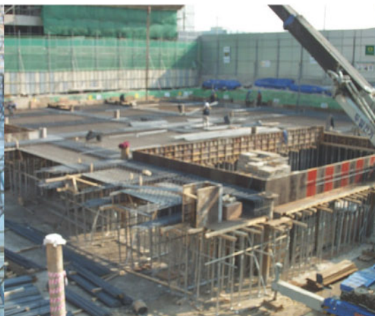
답십리 주택 재개발 신축공사 현장
